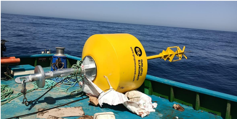
En las ilustraciones se refleja el montaje y adaptación de las boyas perimetrales, castilletes y luz perimetral.
